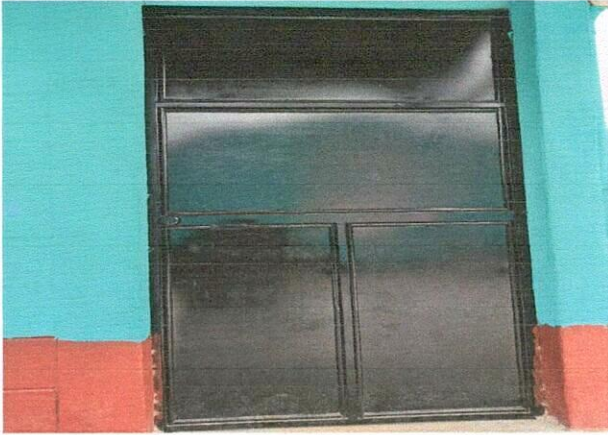
Foto 7: Finalización de mejoramiento de cocina (puerta)
