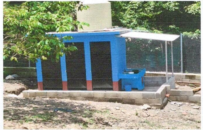
Foto 4: Finalización de Mejoramiento de baños (cambio de sanitarios, puertas, pintura, pila)
