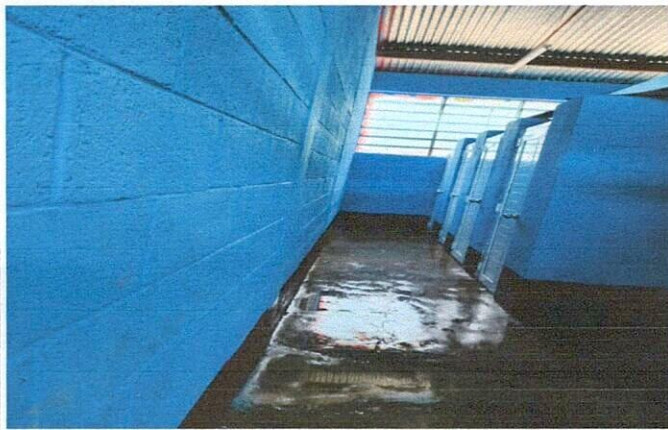
Foto 3: Finalización de Mejoramiento de baños (puertas, pintura)
