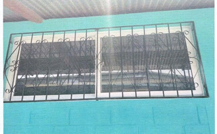
Foto 8: Finalización de mejoramiento de ventana y balcon aula de prepa
